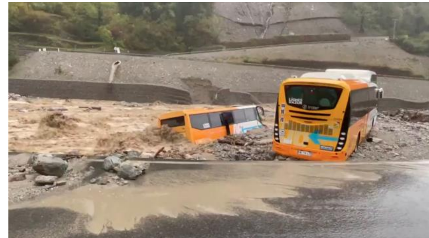
Les dégâts des crues soudaines à St Martin Vésubie provoquées par (a) la tempête Alex en oct. 2020 et (b) la tempête Aline en oct. 2023
